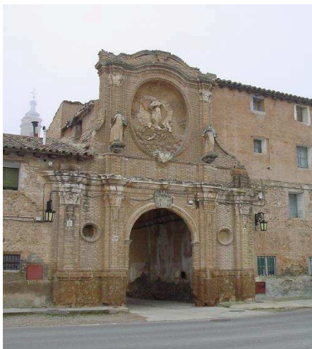
Acceso al monasterio y murallas
