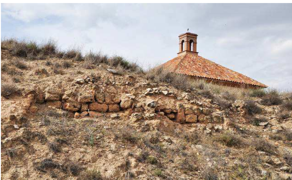
Restos constructivos junto a la ermita
