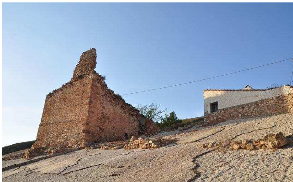
Dos vistas de la torre de Homenaje, asentada sobre un estrato rocoso en plano inclinado
