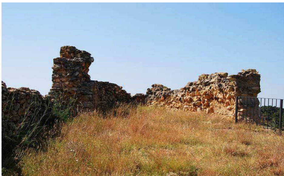
Vista de los muros desde el interior
