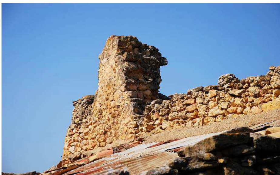
Uno de los muros conservados
