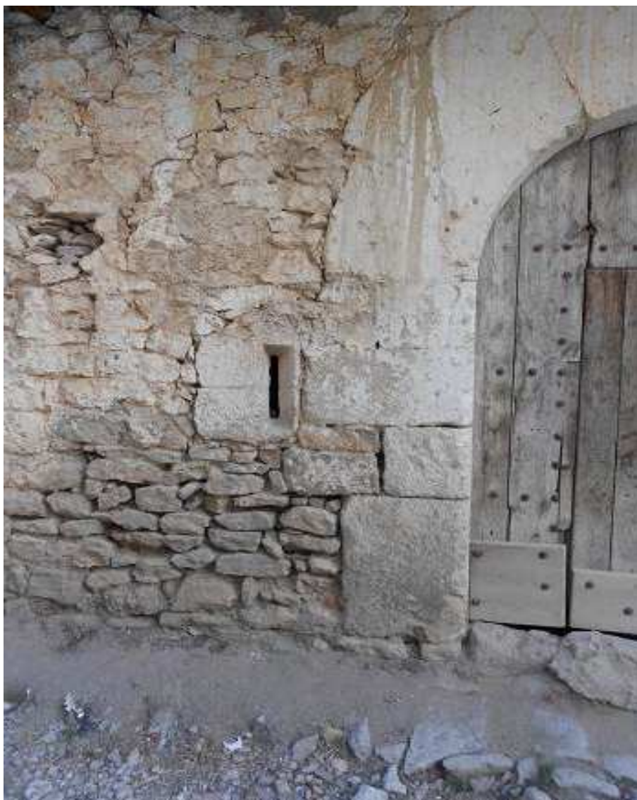
Detalle de aspillerera y parte de la puerta
