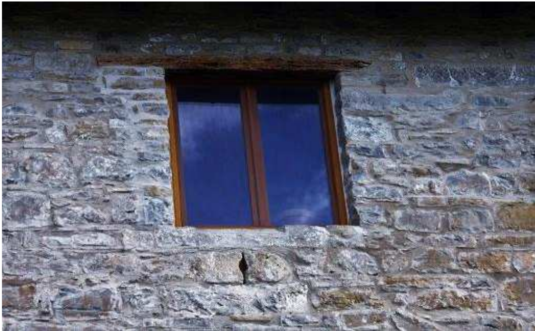
Detalle de la ventana con la aspillera bajo ella
