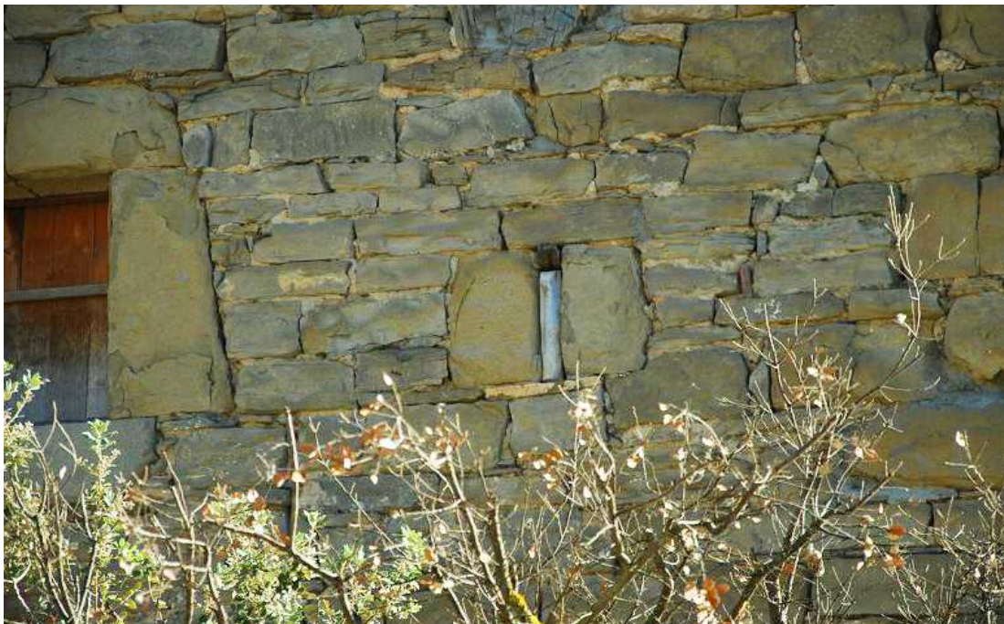
Detalle del vano aspillado
